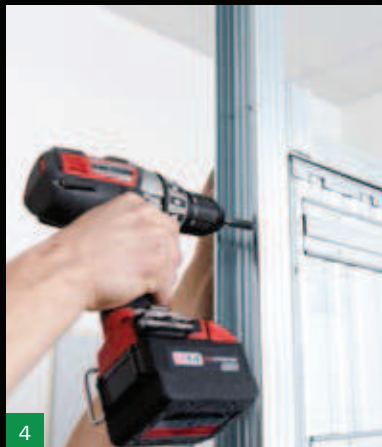
Připevnění pouzdra ke konstrukci SDK
